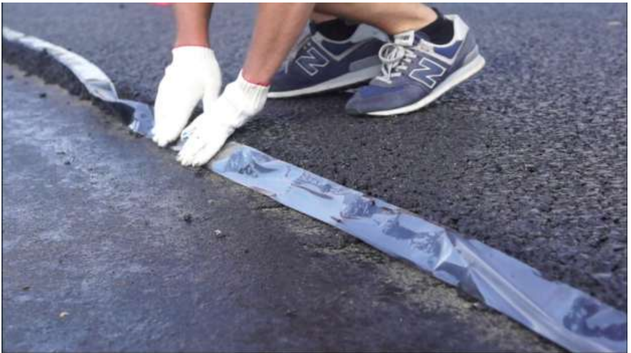
Рисунок 6 – Процесс ремонта шва с применением ленты
