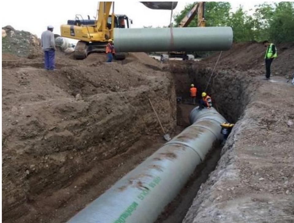
Рисунок 1. Подземная укладка газопровода
