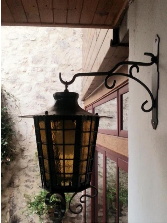
Рисунок 2.3 - Наружное консольное крепление светильника - внутреннее – монтируется в помещениях (монтаж на стены, потолки, полы, несущие перегородки и конструкции).
