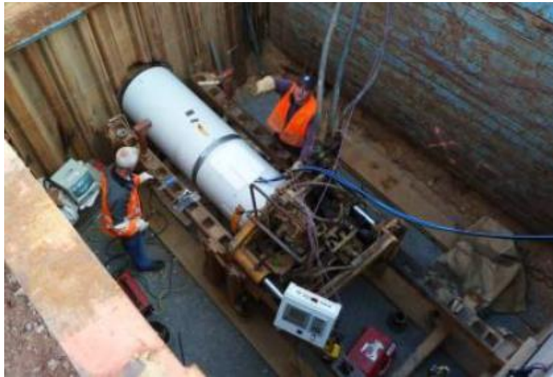
Рисунок 4. Внешний вид процесса микротоннелирования
