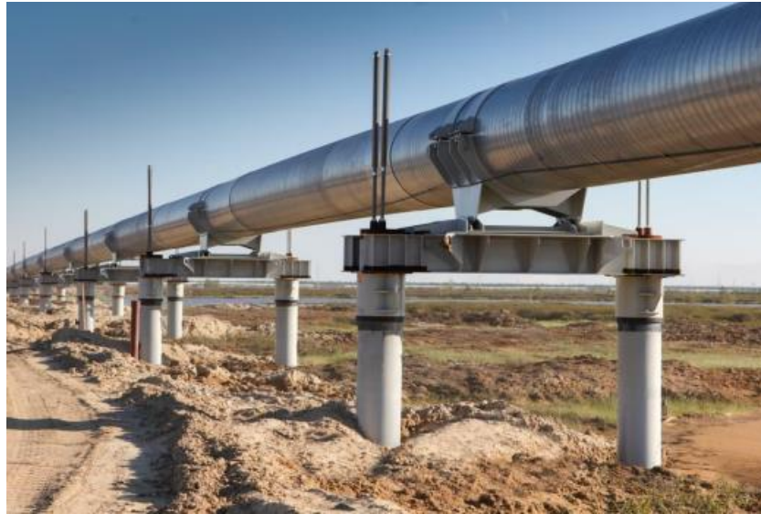
Рисунок 3. Наземный способ прокладки газопровода
