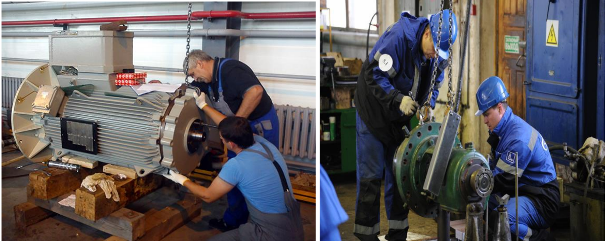
Рисунок 2 - Монтаж электрических машин
