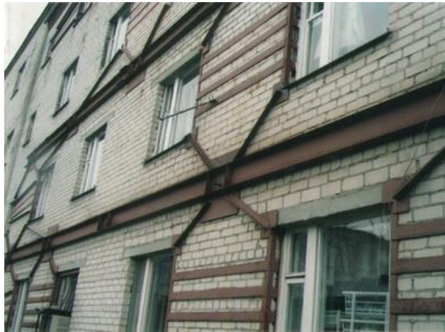
Рисунок 1. Усиление обоймами из прокатной стали.
