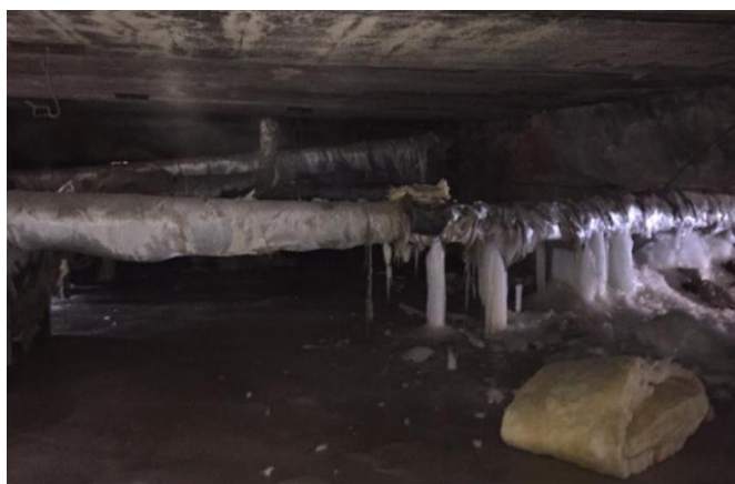
Рисунок 1. Фактическое состояние проветриваемого подполья здания
