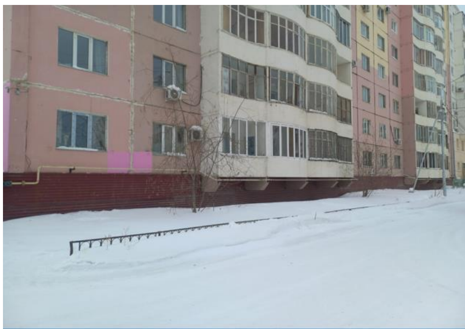
Рисунок 1. Проветриваемое подполье с занесенным зазором для проветривания
