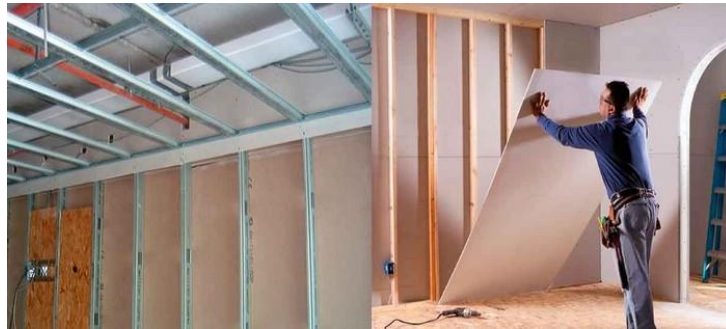
Рисунок 4. Монтаж гипсокартонного листа на каркас
