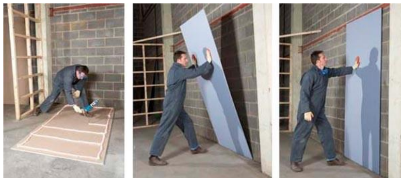
Рисунок 5. Бескаркасный монтаж гипсокартонного листа
