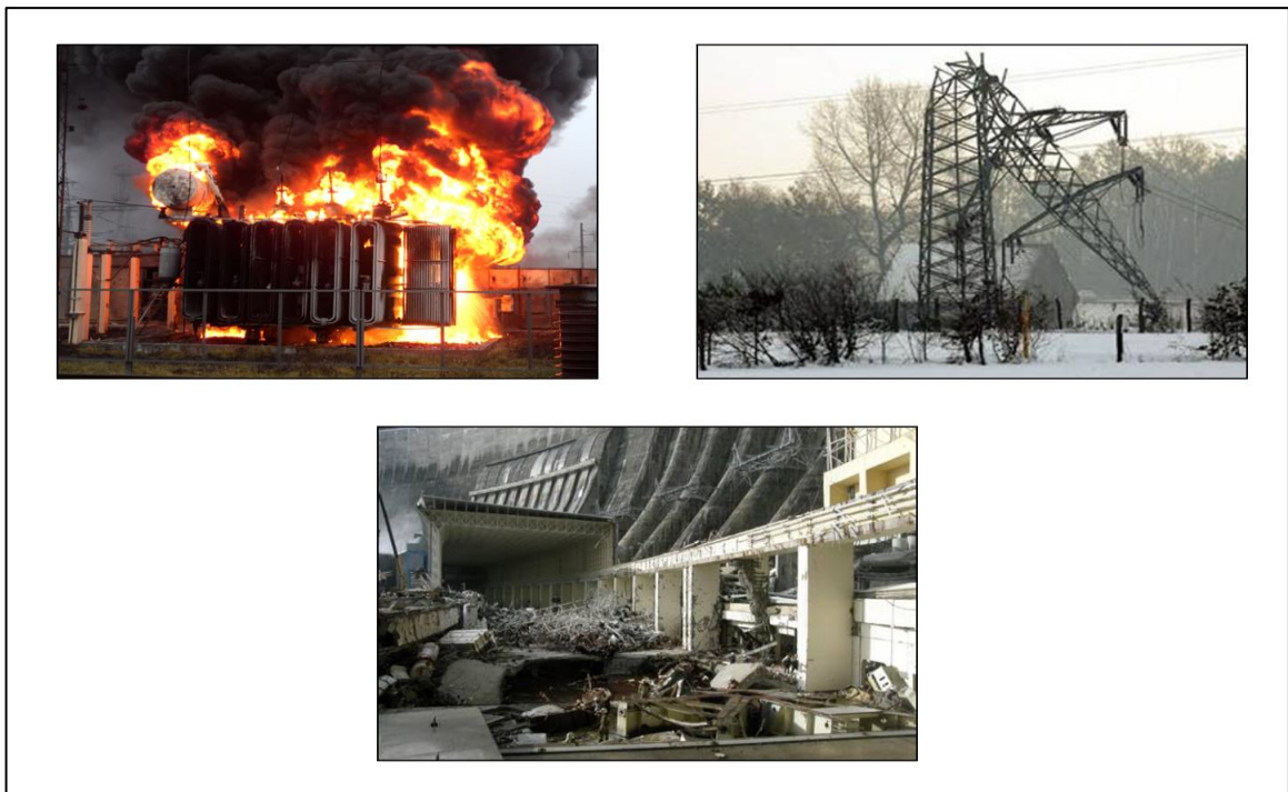
Рисунок 1 – Виды энергетических аварий
